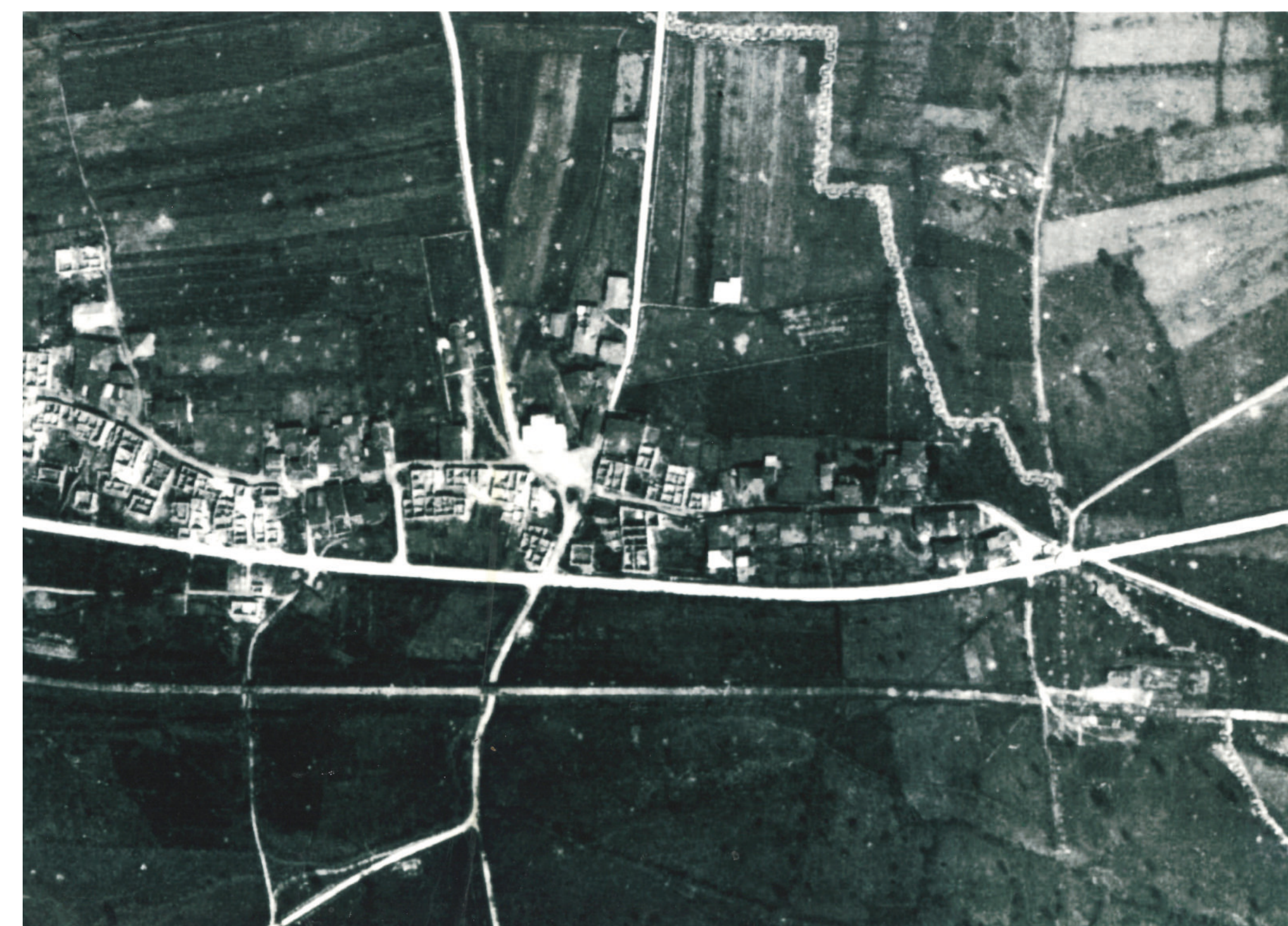
Foto aerea Castelnuovo - 1917
