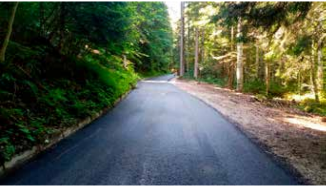
Strada forestale "Val delle Tavole – Lanzoletta" riasfaltata. (foto del custode forestale)
