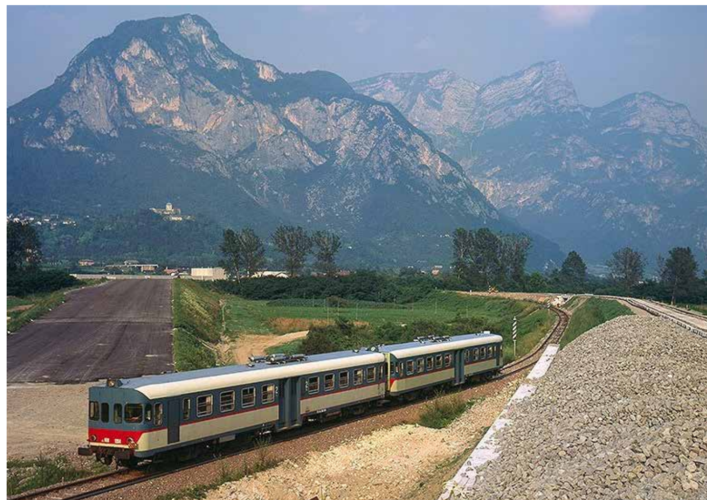
1995 si lavora al nuovo sovrappasso ferroviario a Castelnuovo
